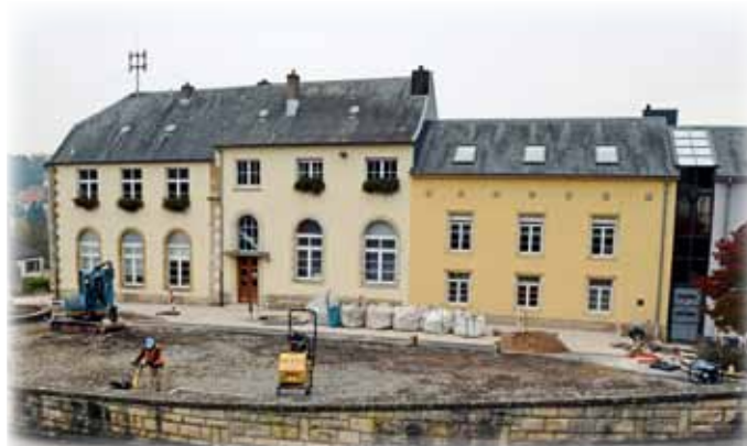
Réaménagement de la cour de la mairie provisoire à Eischen
