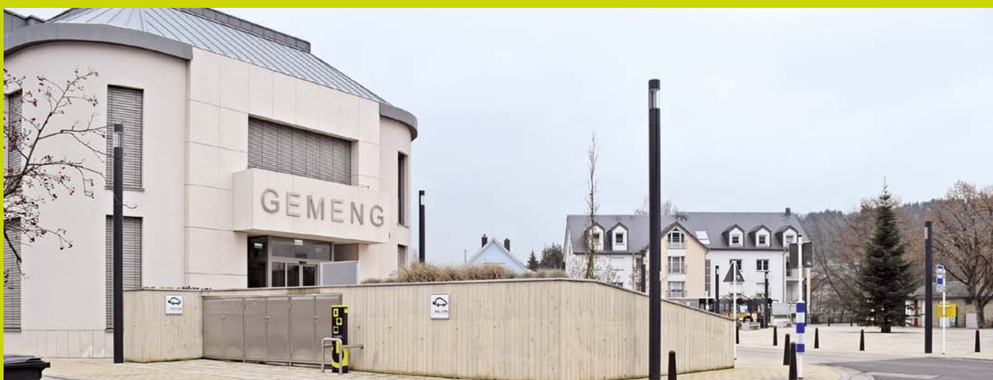
La borne «Chargy» à Eischen se trouve derrière la Maison communale dans la rue de Clairefontaine.
